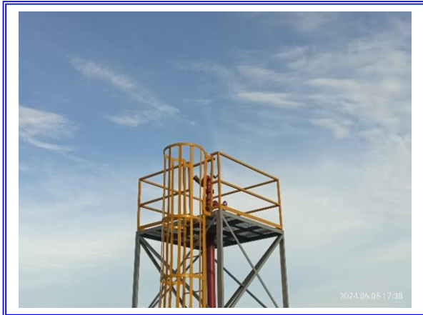
รูปที่ 3-31 Fix Monitor (หัวฉีดน้ำดับเพลิงบริเวณหน้าท่า)
