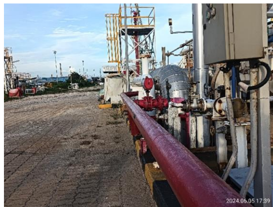
รูปที่ 3-2 Curb ป้องกันการรั่วไหลของสารเคมี
