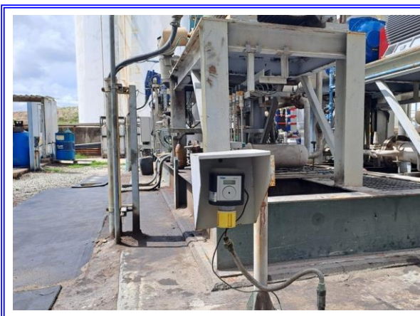
รูปที่ 3-38 (ต่อ) อุปกรณ์การตรวจวัดก๊าซแอมโมเนีย
