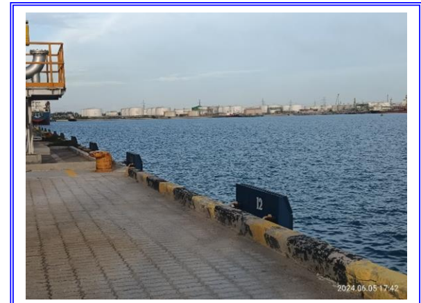
รูปที่ 3-9 Fender ป้องกันเรือกระแทกท่า
