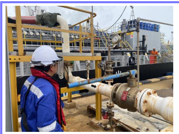
รูปที่ 3-37 นายทำตรวจการเชื่อมต่อท่อก่อนการสูบน้ำถ่ายสินค้า
